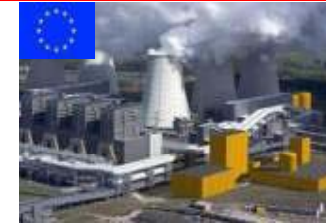
Vattenfall Jämschwalde Germany - 250 MWe Oxy - Lignite
