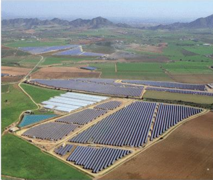
Fuente Álamo (36MW) - SPAIN
